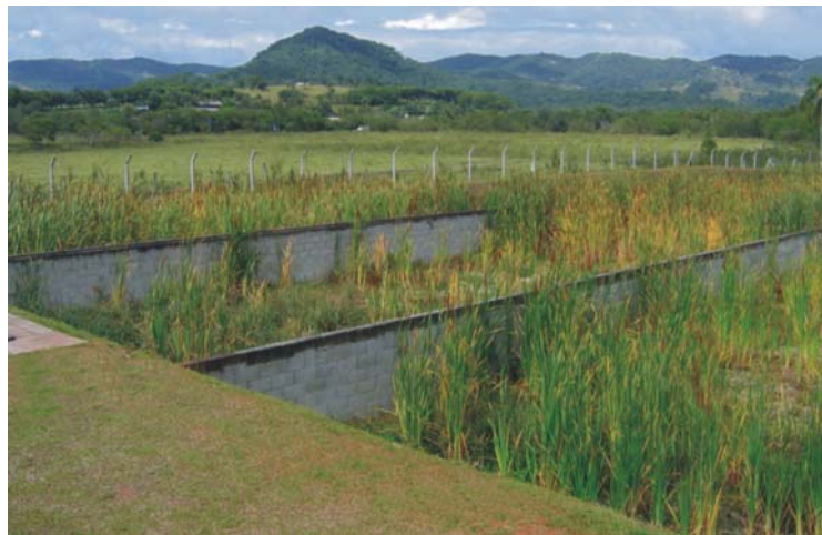
Canteiro de mineralização de lodo
