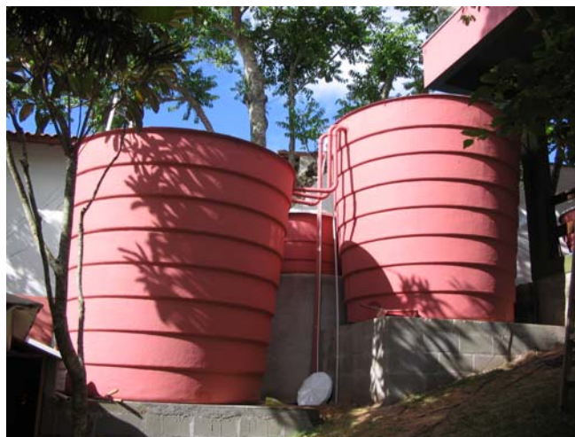
Soluções ideias para o tratamento de esgotos
